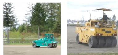
小中学校のグラウンドでの転圧
