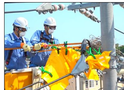
【ホットスティックを使ったカラスの巣の撤去作業】
